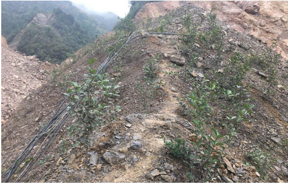
图 2-5 边坡栽植乔木复绿
