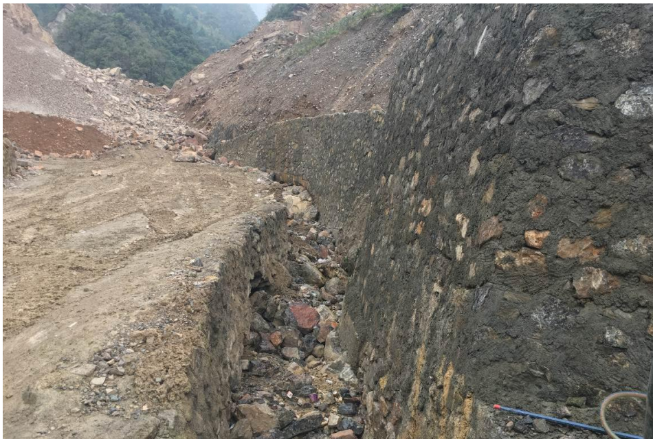
图 2-6 石洞沟进行疏浚和浆砌块石加固
