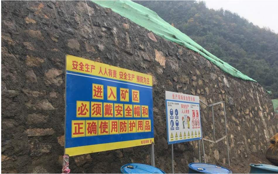
图 2-7 底部平台表土堆场修筑挡墙
