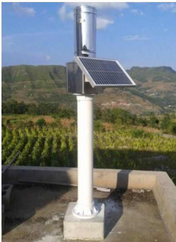
图 5-10 自动雨量监测站
