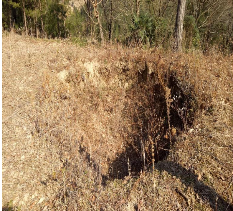
照片 3-4 1#塌陷 (TX01) 概貌
