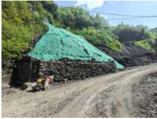
临时堆场及下部挡墙
