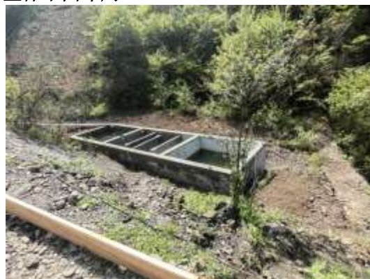
下部沉淀池及下部挡墙
