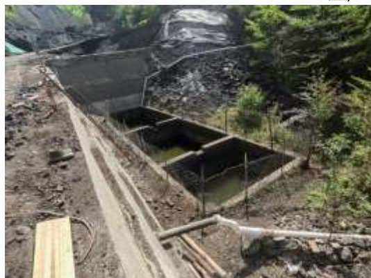
上部沉淀池及堆场间挡墙
