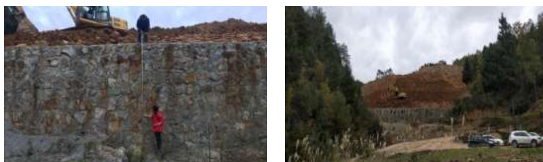
图 2-7 1 号废石堆挡墙治理
