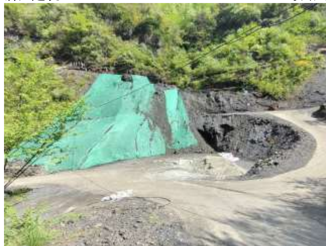
临时堆场及各级平台 图 3-1 P1-2#工业广场
