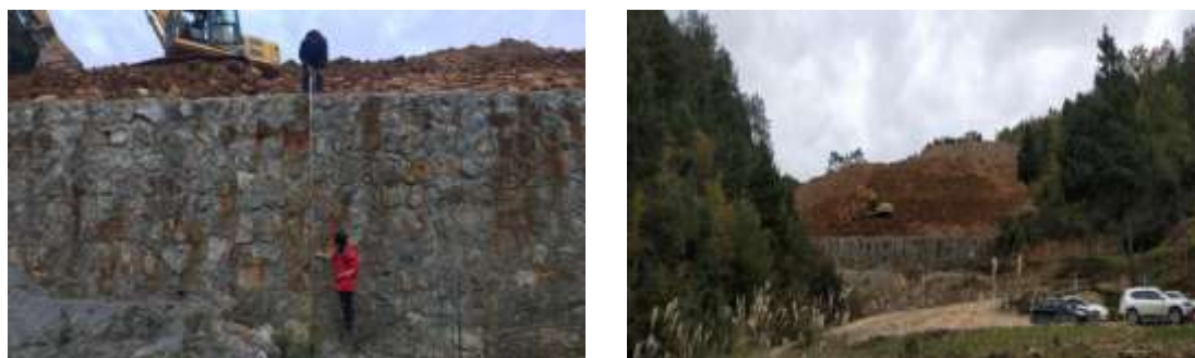
照片 2-6 1 号废石堆挡墙治理
