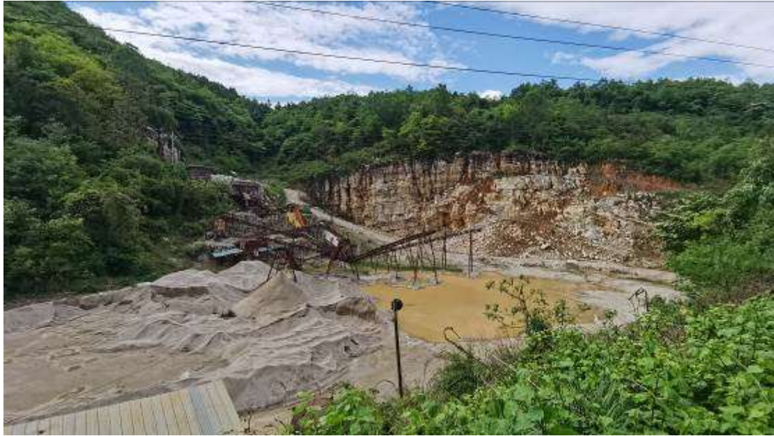
照片 1-1 废弃老采场现状
