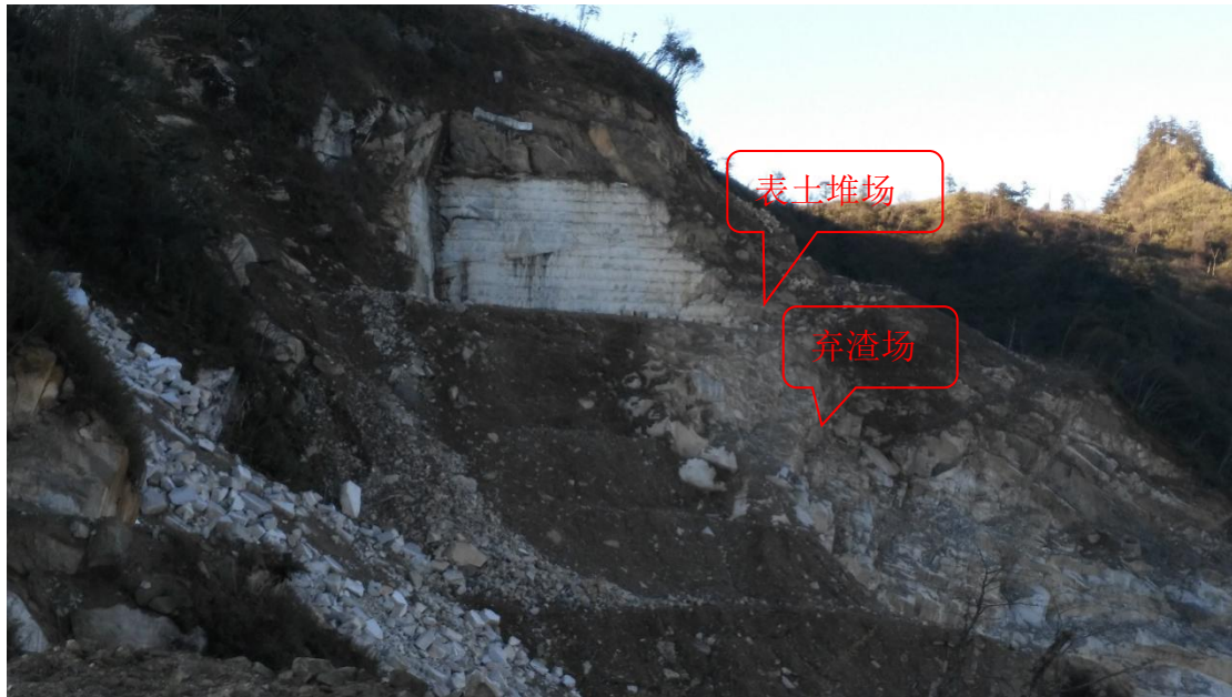
图 1-3 废渣场全景现状
